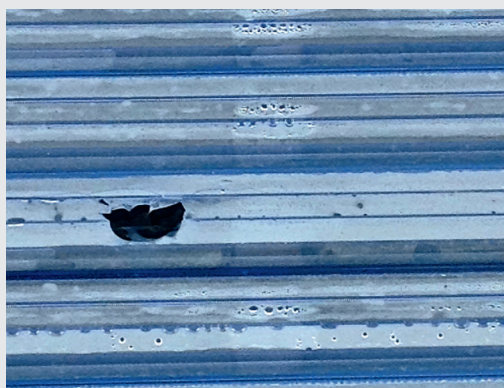
Même si le vieillissement n'est pas apparent, les matériaux en plastique peuvent eux aussi perdre leur protection initiale contre la grêle.
