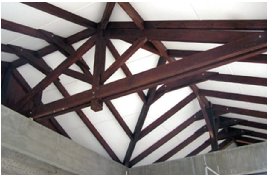
Les éléments porteurs linéaires RF3 (solivage ou chevrons bois par exemple) sont tolérés dans les voies d'évacuation selon l'alinéa 7 du même tableau.
