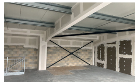
Intérieur d'un lot, structure métallique protégée (photo de Fire Safety & Engineering SA)
