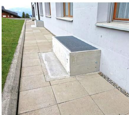
Figure 8 : rehaussement de saut-de-loup et diminution de sa largeur
