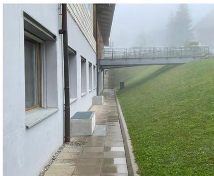
Figure 9 : perspective des sauts-de-loup rehaussés le long de la façade et leur diminution de largeur
