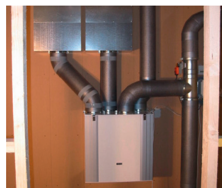
Exemple d'installation de ventilation Minergie
