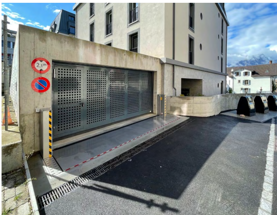
Montreux, batardeau automatique (Klappschott), © ECA
