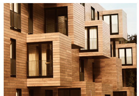
Exemple de revêtement en bois d'une construction
