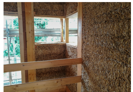
Utilisation de la paille comme matériau de construction renouvelable
