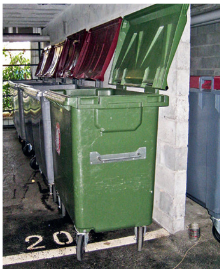
Les containers à déchets représentent un danger d'incendie particulier et, de fait, ne peuvent pas être admis dans un parking. Ils doivent être entreposés soit à l'extérieur, soit dans un local spécifiquement compartimenté coupe-feu par rapport aux autres locaux.
