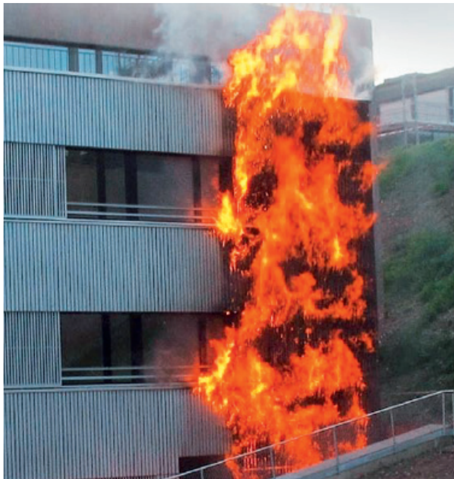
Propagation du feu le long d'une façade ventilée
