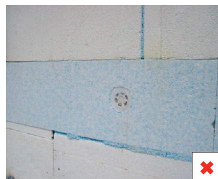
Cheville à taper, posée en surface
