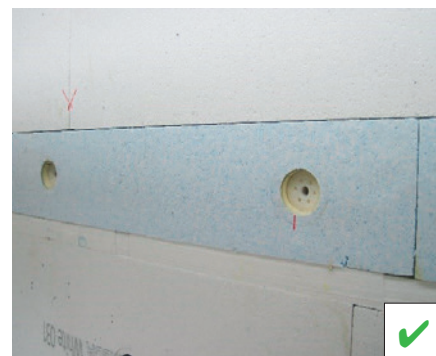
Chevilles vissées, posées à la bonne profondeur
