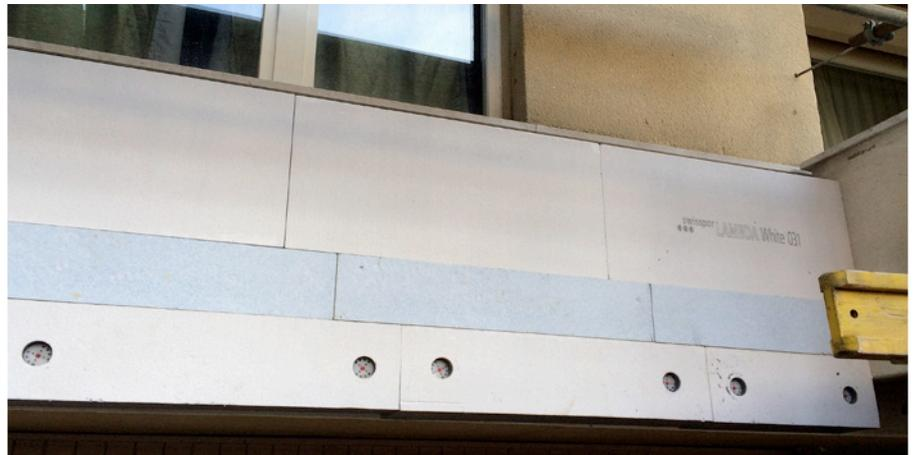
Pose d'une bande filante selon ITEC (en bleu) sur une façade avec isolation combustible
