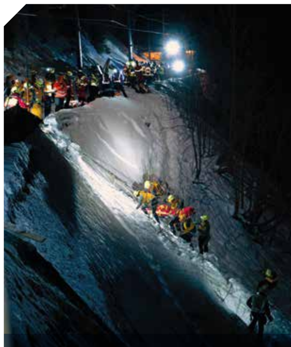
Une zone d'intervention particulièrement difficile d'accès.
